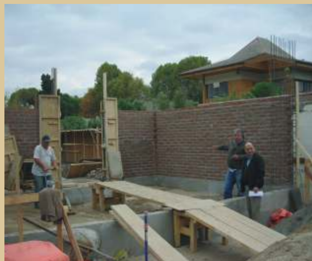
La obra se construye aledaño a la sede del Regional Valparaíso.
